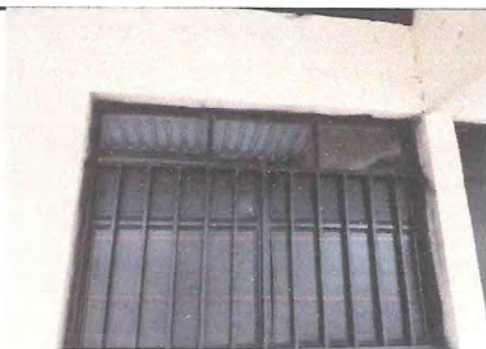
Foto 3: Mantenimiento de ventanas finalizado
