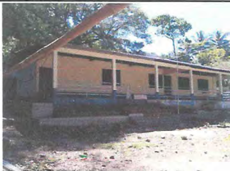
Foto1: Banquetas y gradas terminadas
